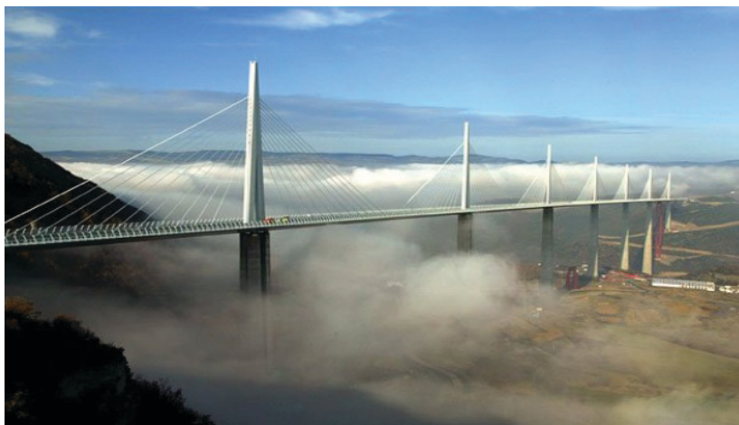
1.42 pav. Millau viadukas Prancūzijoje ( http://www.funonthenet.in/content/view/190/31/ )
