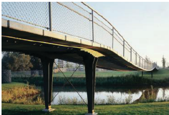
2.3 pav. Vienajuostis kabamas pėsčiųjų tiltas Rostoke, Vokietijoje
