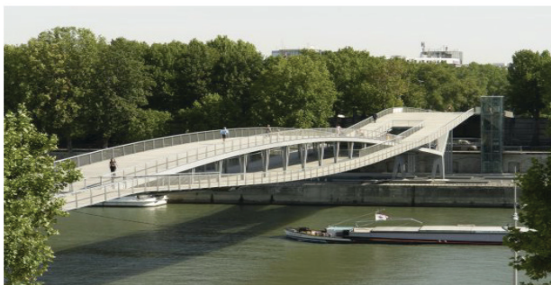
3.16 pav. Simone de Beauvoir pėsčiųjų tiltas, 2006 m, Prancūzija
