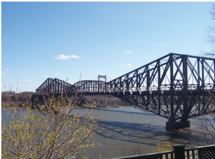
1.3 pav. Pont de Quebec tiltas Kanadoje
