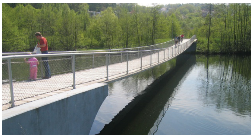
1.26 pav. Pforzheim III tiltas Vokietijoje http://www.sbp.de/en/build/sheet/56Enzaupark_Pforzheim_Steg_III.pdf )
