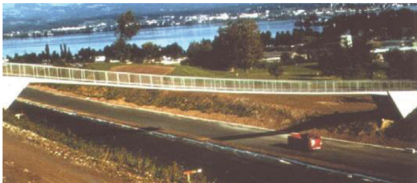
2.2 pav. Bicherweid vienajuostis kabamas pėsčiųjų tiltas Šveicarijoje
