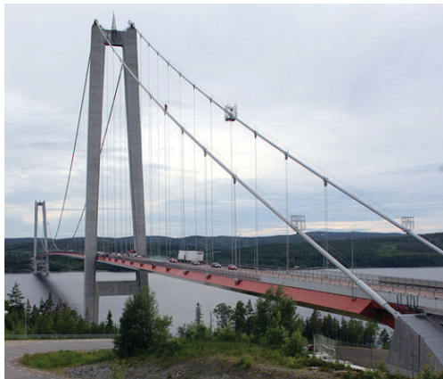
1.6 pav. Höga Kusten tiltas su masyviais lynų inkaravimo pamatais ( http://commons.wikimedia.org/wiki/File:Hoga_kustenbron_Sweden.jpg )
