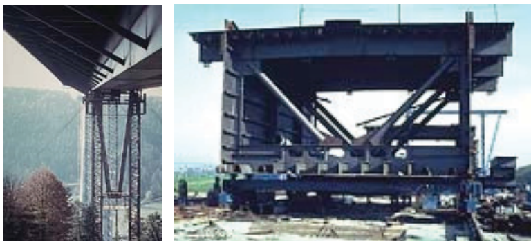
3.18 pav. Dėžinio skerspjūvio standumo sija, Neckar Valley viadukas (Weitingen, Vokietija 1978 m.)
