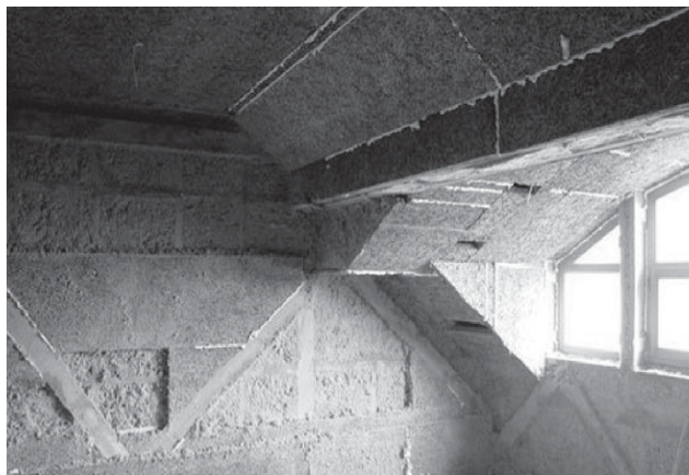
4.8 pav. Pastato atitvarų įrengimas iš medienos ir cemento kompozito plokščių
