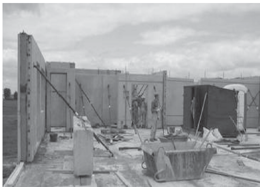
3.27 pav. Trisluoksnių sieninių plokščių montavimas (a, b)
