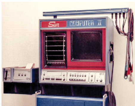
14 pav. Firmos SUN variklių patikros standas (apie 1970 m.)
