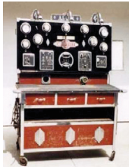
13 pav. Firmos ALLEN automobilių elektros įrenginių diagnostavimo stendas (apie 1930 m.)
