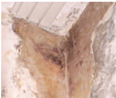
3.9 pav. Patalpose su padidintu santykinio oro drėgnumu užsiveisę pelėsiniai grybai – mikromicetai
