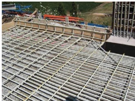
6.2 pav. Viaduko plokščių pakeitimas Ontario, Kanadoje („Schöck Bauteile GmbH“)
