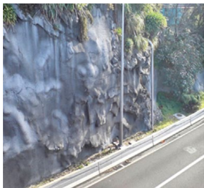
1.13 pav. Šlaitų ir tunelio sienų torkretavimas dispersiškai armuotu betonu
