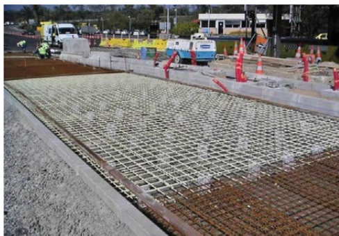
6.4 pav. Kelio plokštės armavimas Péage de Tain, Prancūzijoje („Schöck Bauteile GmbH“)
