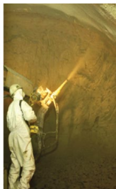
1.13 pav. Šlaitų ir tunelio sienų torkretavimas dispersiškai armuotu betonu
