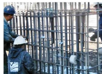
6.9 pav. Tunelio statybos Briuselyje. Naudojama stiklo pluošto armatūra (Aslan 100)
