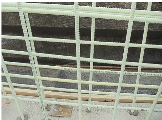
6.3 pav. Viadukas, pastatytas 2010 m. Ontario, Kanadoje. Naudojama stiklo pluošto armatūra („Schöck ComBAR“)
