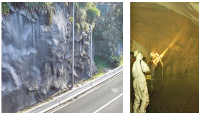
1.13 pav. Šlaitų ir tunelio sienų torkretavimas dispersiškai armuotu betonu
