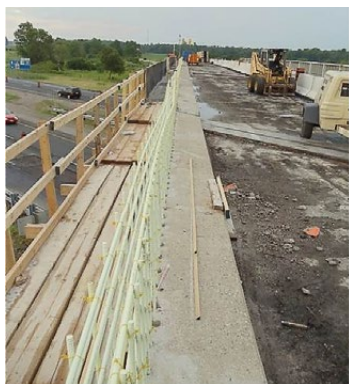
6.3 pav. Viadukas, pastatytas 2010 m. Ontario, Kanadoje. Naudojama stiklo pluošto armatūra („Schöck ComBAR“)
