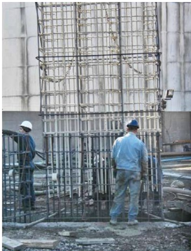
6.9 pav. Tunelio statybos Briuselyje. Naudojama stiklo pluošto armatūra (Aslan 100)
