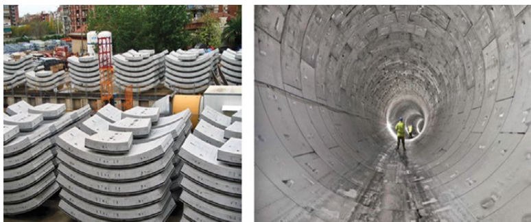
1.10 pav. Plieno ir polipropileno plaušu armuoti segmentai, naudojami tiesiant tunelius
