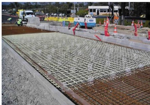
6.3 pav. Viadukas, pastatytas 2010 m. Ontario, Kanadoje. Naudojama stiklo pluošto armatūra („Schöck ComBAR“)
