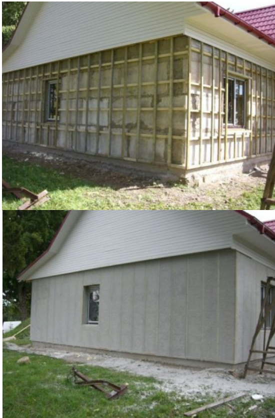
5.22 pav. Vertikaliųjų paviršių ruošimas darbui ir šiltinimas ekovata
