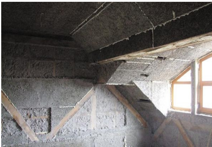
5.35 pav. Pastato atitvarų įrengimas iš fibrolito plokščių
