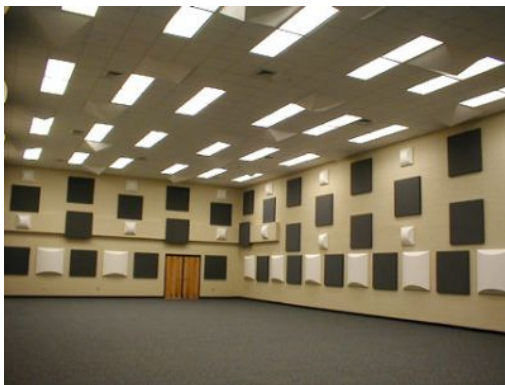
1.3 pav. Sienos padengtos garsą sugeriančiais ekranais
